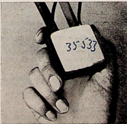
Afb. 9 - EEN SIEMENS FRIGISTOR, voorziën van waterkoeling
